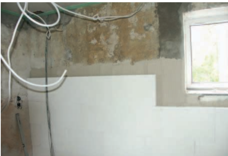
Beim Einbau der Mineralschaumplatten wird gezielt auf die Dampfbremse verzichtet. Der kapillaraktive Baustoff trägt zu einem behaglichen Raumklima bei. Auch bei einer späteren Renovierung sind möglichst diffusionsfähige Materialien zu verwenden.
