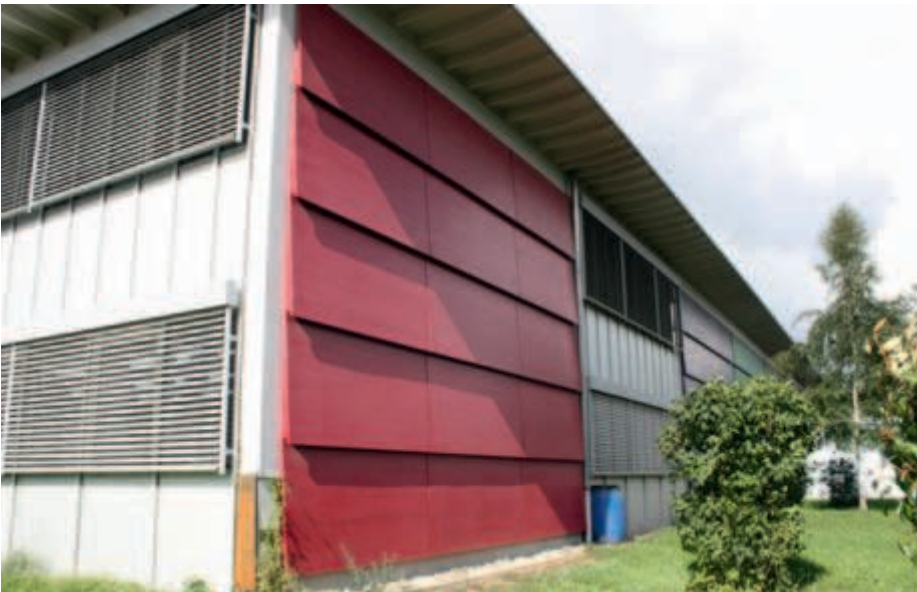
Sechs Jahre später, im August 2010, immer noch in einem einwandfreien Zustand. Zu sehen ist die Südseite – die Hauptwetterseite West (links) wurde mit eloxiertem Aluminium bekleidet. Ein gutes Beispiel für den architektonisch geschickten Umgang mit dem Baustoff Holz
